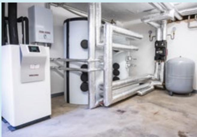
Blick in den Heizungskeller: Inneneinheit der Wärmepumpe (links) und die beiden Pufferspeicher (Mitte)
