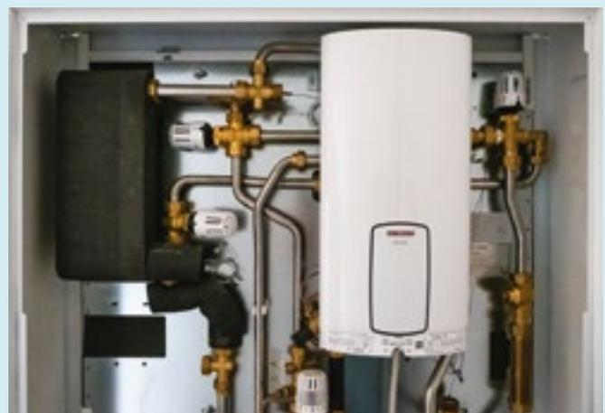
Blick in die Wohnungsstation 1: Der elektrische Durchlauferhitzer springt ein, wenn höhere Trinkwassertemperaturen benötigt werden.
