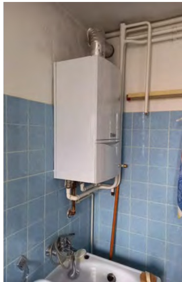
Gasetagenheizung vor der Sanierung ©Spar- und Bauverein eG
