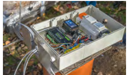
Installation der Steuerungstechnik für das Bewässerungssystem
