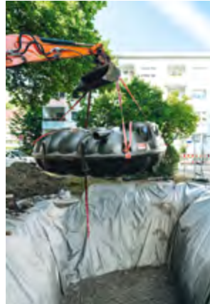
Die Zisterne wird unterirdisch installiert
