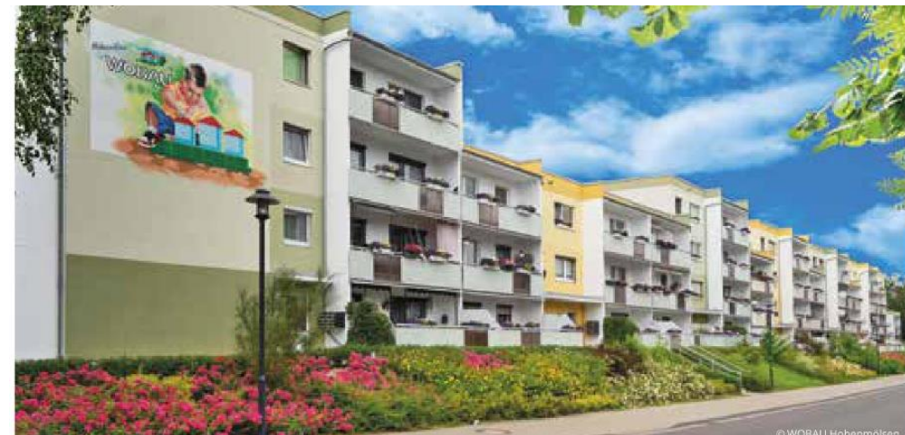
Hohenmölsen: Teilrückbau mit Dachterrassen und Mietergärten
