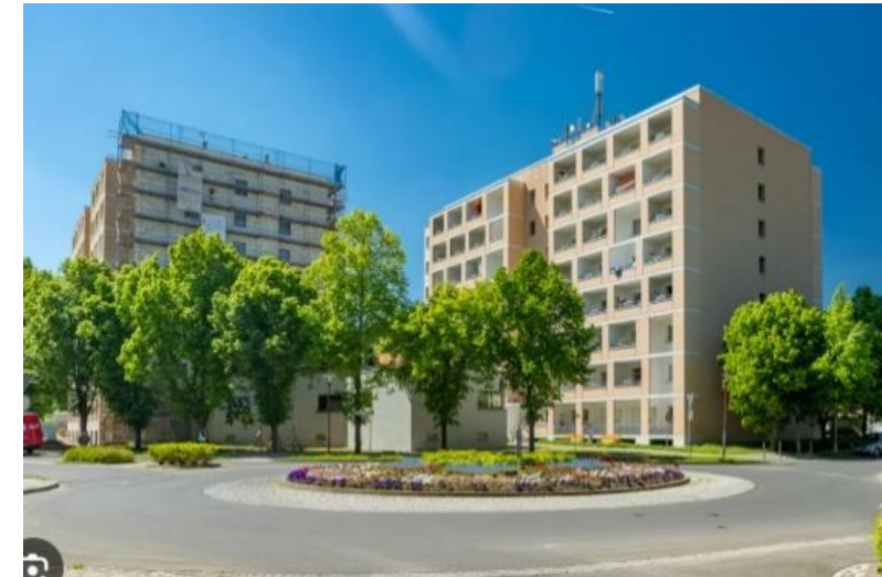
Sömmerda/Thür.: Umbau von zwei Punkthäusern für betreutes Wohnen
