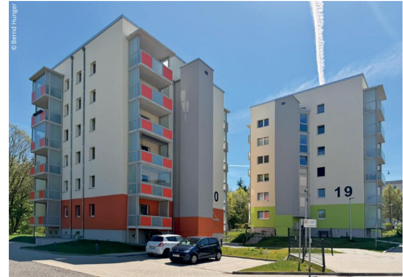
Ilseburg/Harz: Sanierte Punkthäuser
