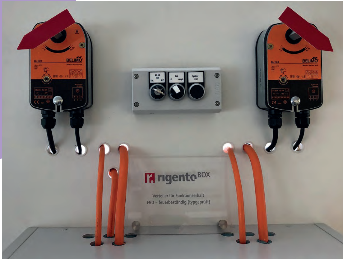
Komponenten des Brandschutzes, hier die Steuerung des Rauchabzuges, lassen sich mit entsprechendem Schutz in die Hausautomation einbinden.
